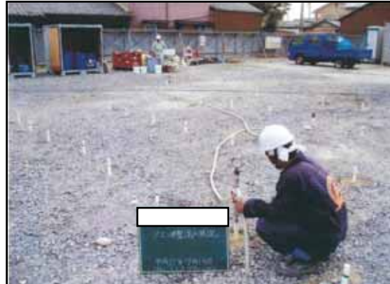
原位置浄化工事
