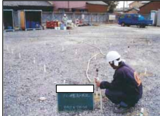
原位置浄化工事
