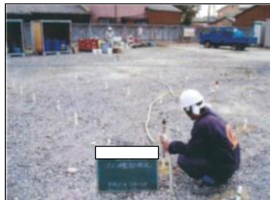
原位置浄化工事
