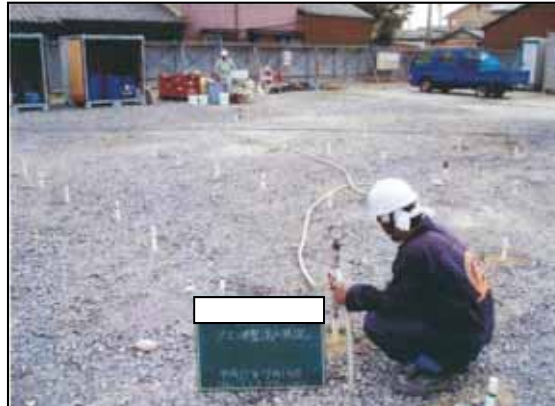
原位置浄化工事
