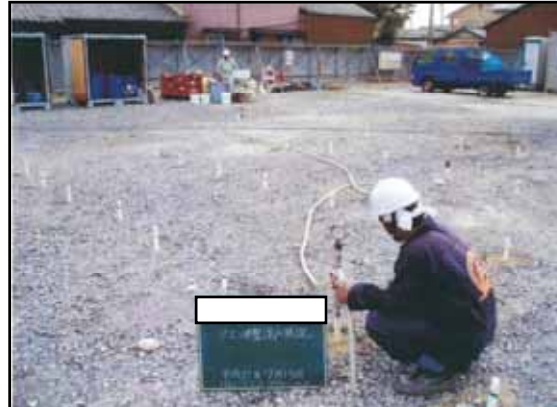
原位置浄化工事
