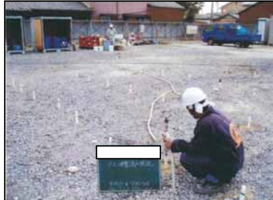
原位置浄化工事
